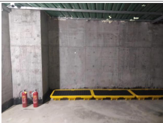
危废库内部照片
