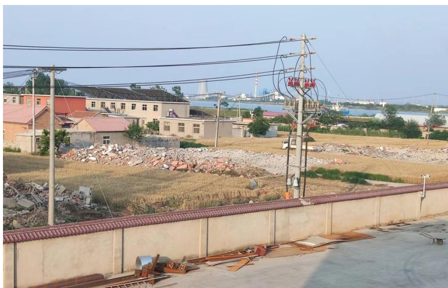
图 3-5 拆迁后现场照片
